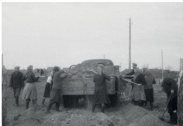
Строительство дороги в Борке, 50-е годы
